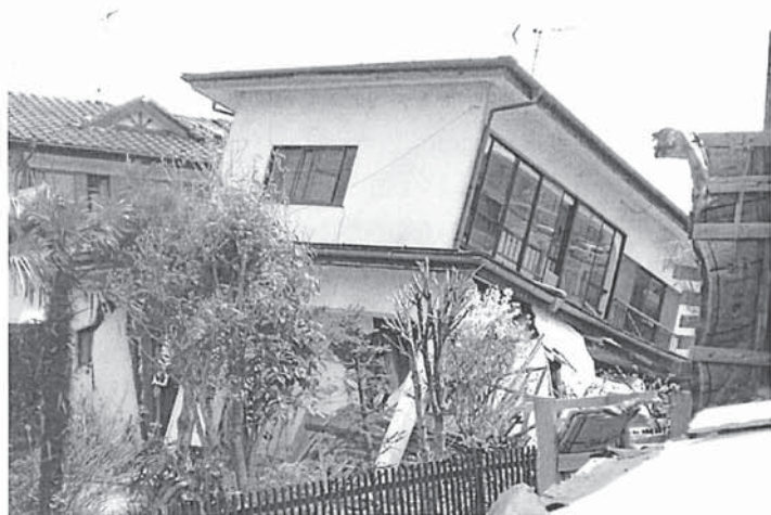
東日本大震災の液状化により傾いた住宅(福島県国見町)
