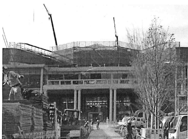
建設中の理科大図書館棟
