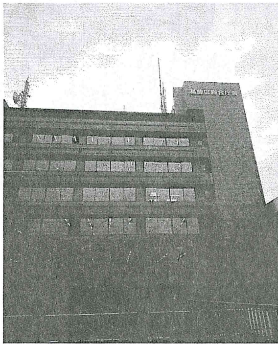
築36年しか経過していない区役所 現新館
