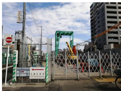
工事が進む連続立体交差化事業
